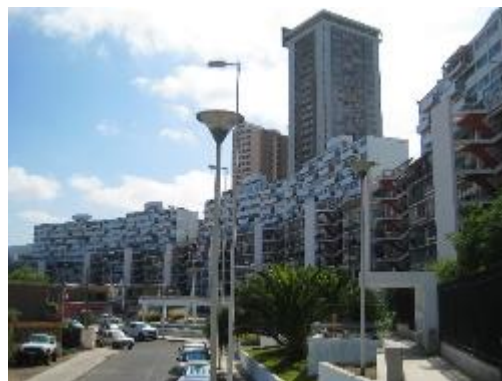
Edificio Huanchaca, también llamado "El Curvo". Fotografía: Pulso SpA – Sur Profesionales.
